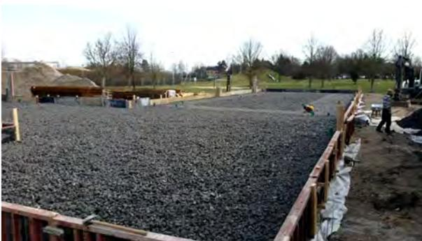
Die gute Ebenheit, der auf Schütthöhe eingebauten **bi-foam Schaumglasschicht** von 39 cm, war Grundlage für eine exakte Verdichtung mit einer abschließenden Höhendifferenz von +/- 2 cm.
