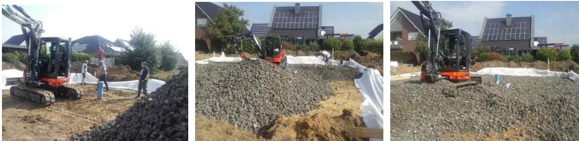
Das Ausbreiten und Einebnen war für die Mitarbeiter mit einer großen Getreideschaufel und Harken kein Problem. Mit dem SGS Bügel, der an einer Bohle befestigt war, wurde die Ebenheit hergestellt und bereits nach 2 Stunden war das perfekte Einebnen der SGS Oberfläche erledigt.
