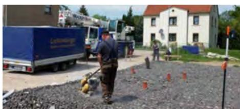
Eine 100 kg Rüttelplatte, welche eine sehr hohe Frequenz hat und 50 cm breit ist, damit für den Einbau von SGS optimiert, war der Einbau und das Verdichten in effektiven 5 Stunden abgeschlossen.
