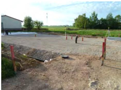
Nachdem der Tiefbauer und die Firma für die Bodenplatten feststanden, wurde der Bodenaustausch eingebaut
