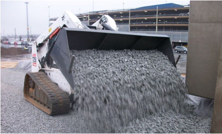
Abbildung 10: Transport und Verteilung des Schaumglas- granulats mit einem Kompaktlader.
