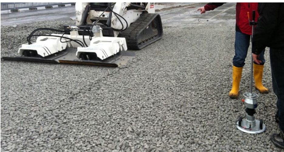
Abbildung 11: Verdichtung des Schaumglas-Granulats mit Anbau-Flächenrüttler
