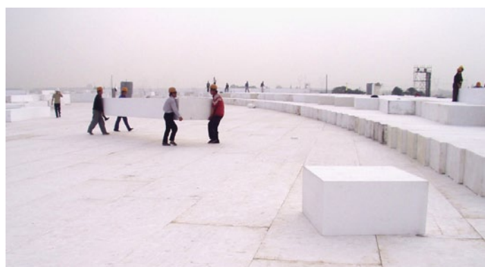
Abbildung 9: EPS-Blöcke können problemlos per Hand zum Einbaort verbracht und dort auf die Zielgröße angepasst werden. Foto: Tilke
